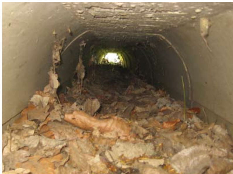
Deels open tunnel (type Aco AT500) met strooisel op bodem (Foto: R. Struijk)
